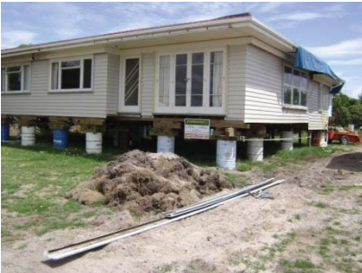
Op Shop on piles
